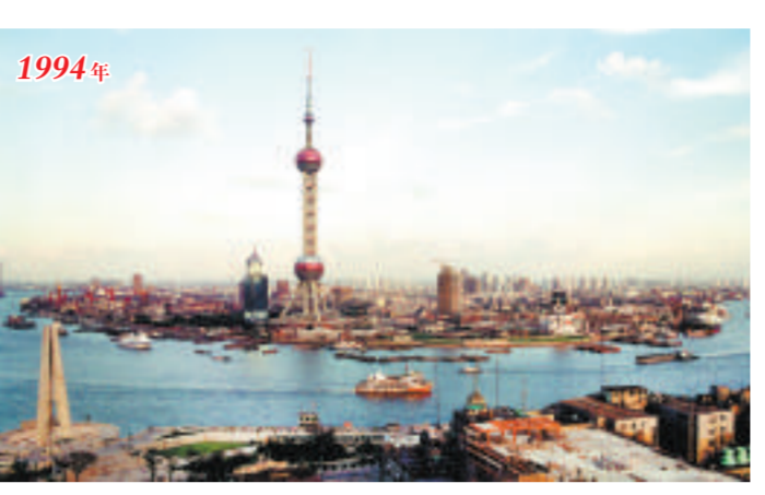
1994年的陆家嘴,东方明珠广播电视塔“一枝独秀”,是上海第一幢超高层建筑,改写了浦东原有的天际线。
