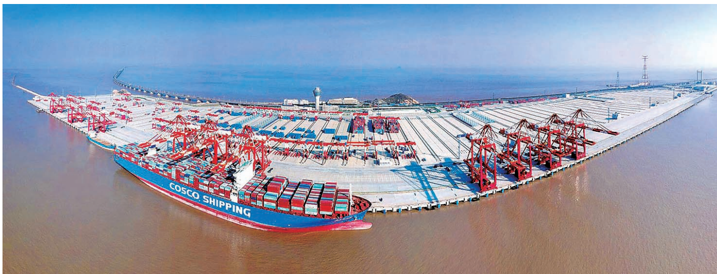
全球单体最大的自动化码头——上海洋山港四期,其码头装备和设备管理系统均由振华重工自主研发。
