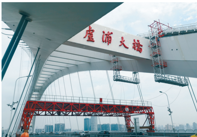
卢浦大桥正在进行桥面钢结构涂装施工。 □本报记者 李继成 摄
