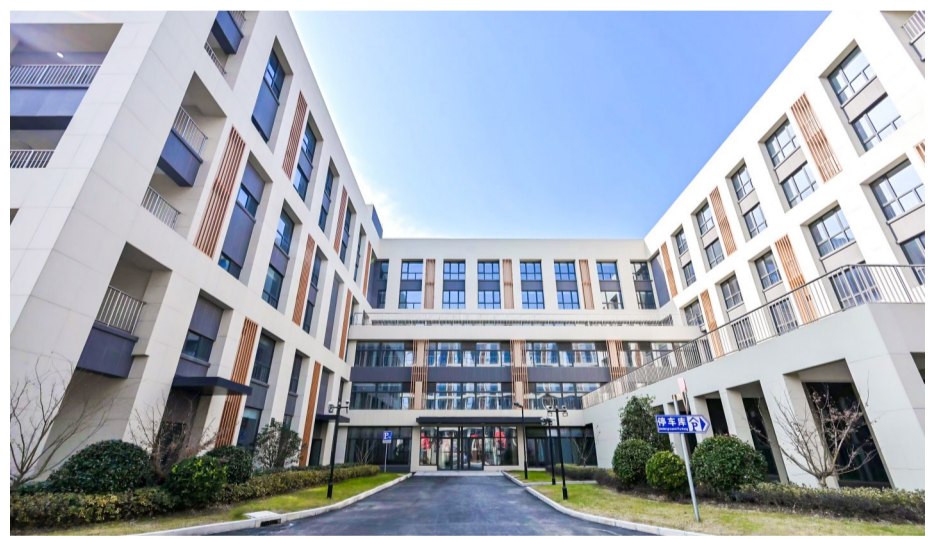
“东西南北中”区级养老机构收官项目——惠南养老院。
